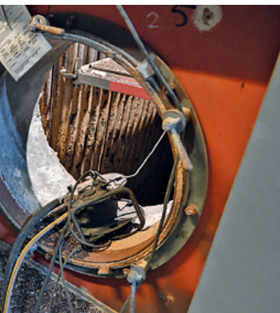
■ Oczyszczanie spalin – wymiana worków filtracyjnych
