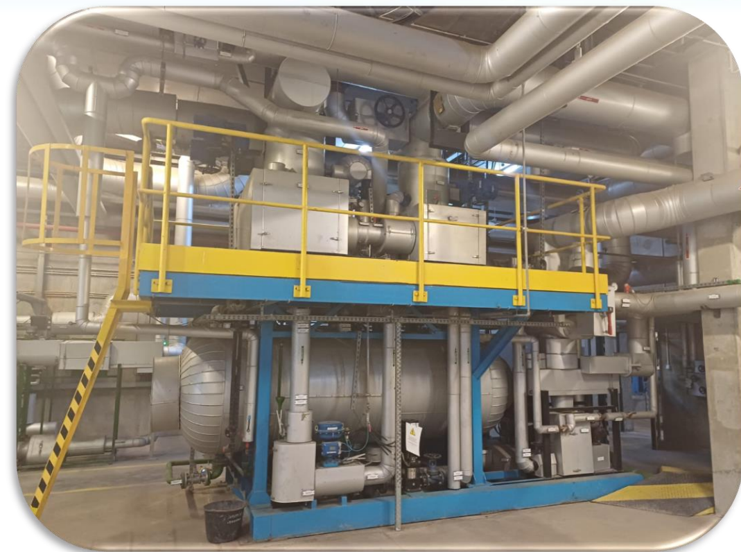
Wymiennik ciepłowniczy sieci miejskiej
