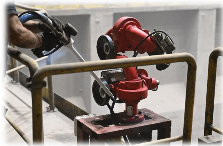
Przygotowanie do czyszczenia suchym lodem
