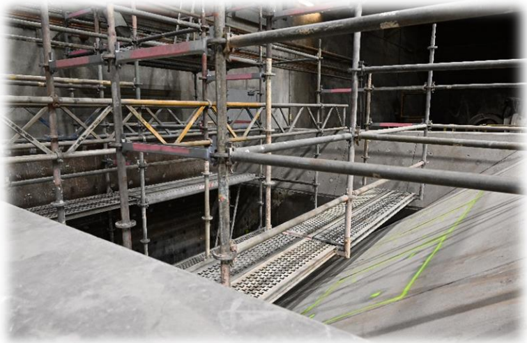
Przygotowanie do czyszczenia suchym lodem
