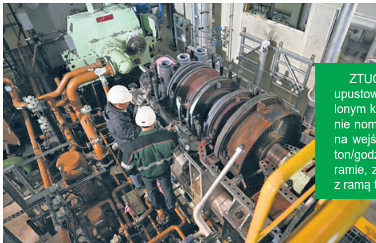
Demontaż turbiny
