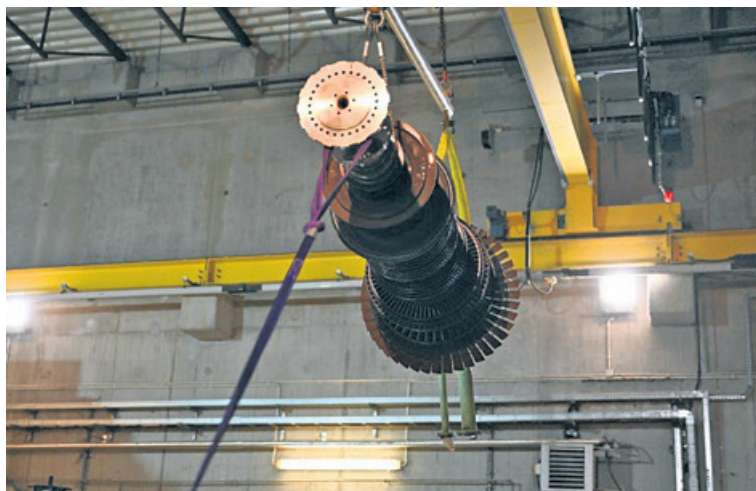
Wyjęcie turbiny
