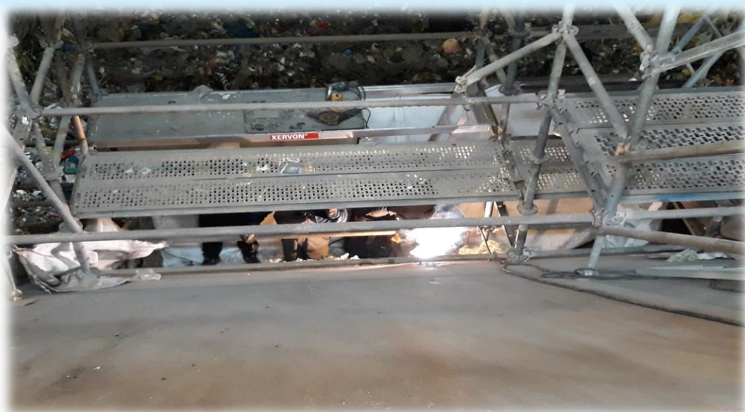
Naprawa zsuwni odpadów w hali wyładunkowej
