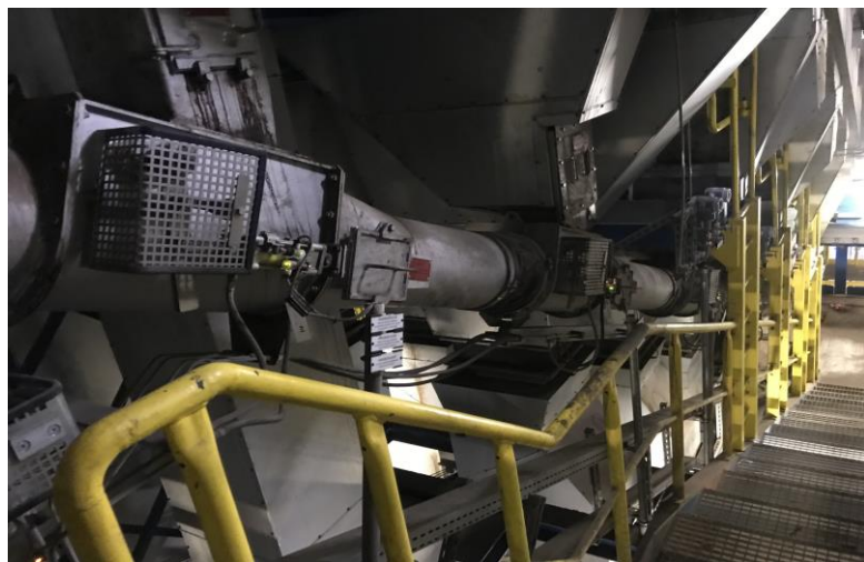
Rurociąg popiołu pod rusztem do odżuźlacza
