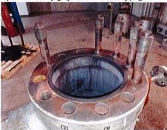
Rys. 18 Zawór odcinający i przyłącze kołnierza regulacyjnego
