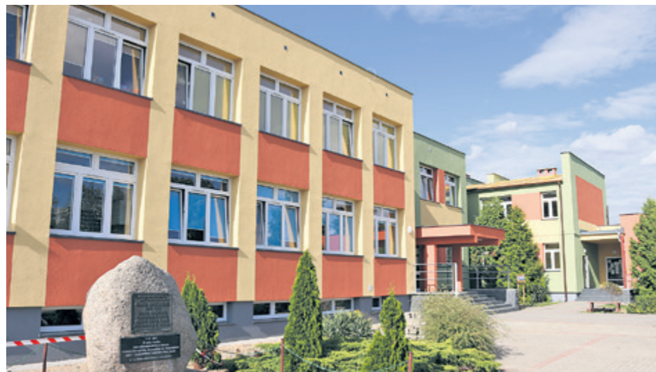
■ Kompleksowa termomodernizacja Szkoły Podstawowej w Sławsku
