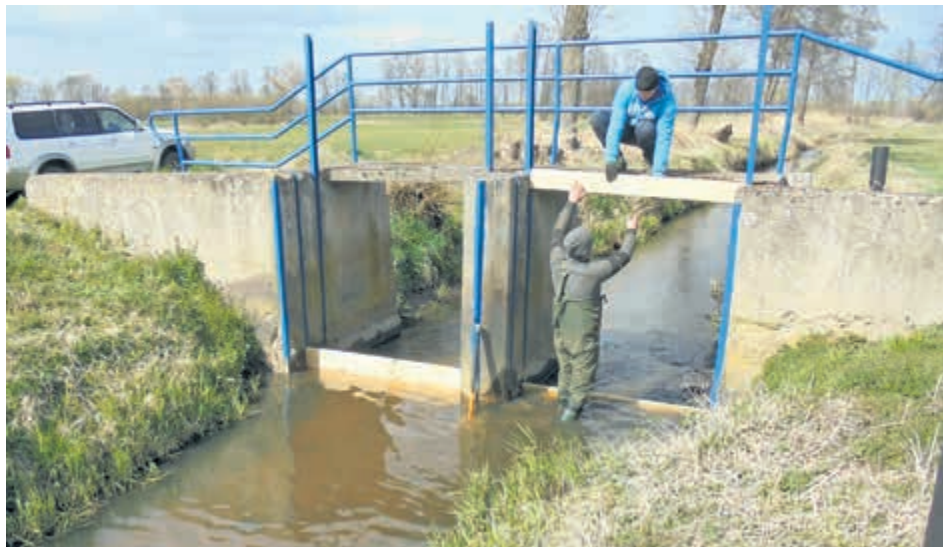
■ Przywracanie funkcjonalności obiektu, który w latach wcześniejszych nie zatrzymywał wody
