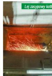
Lej zasypowy kotła
