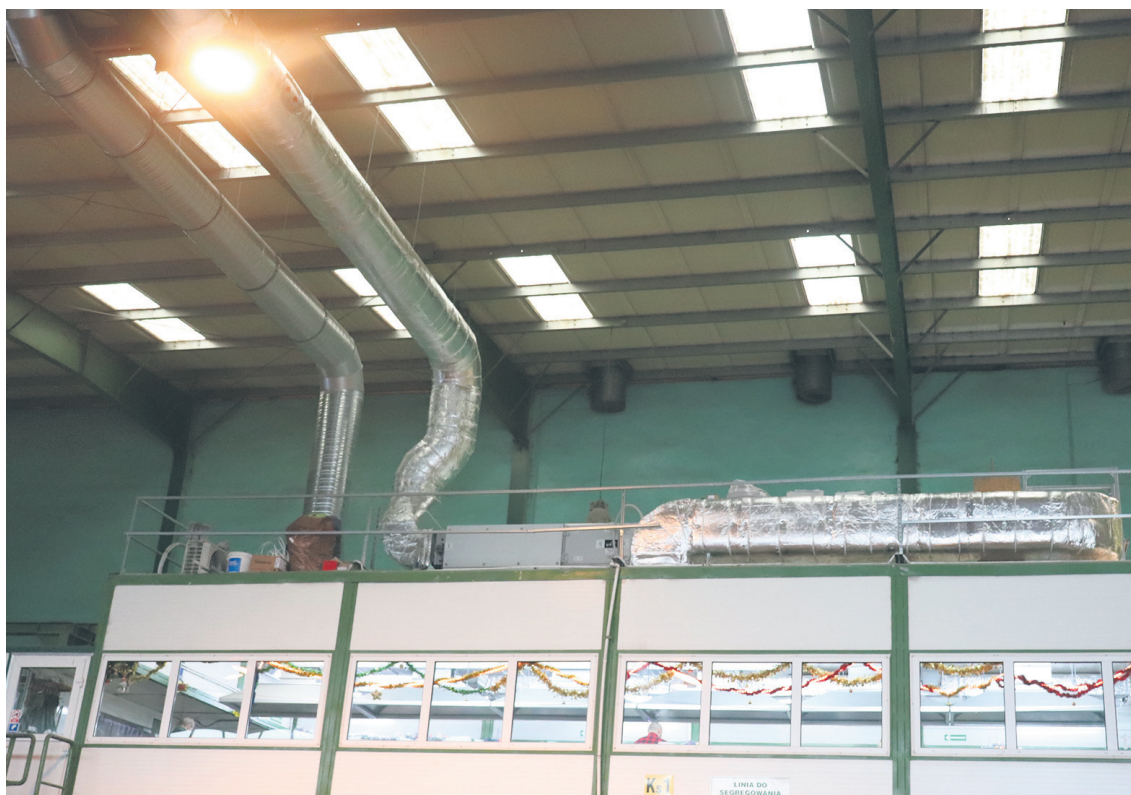
Przedmiotem zamówienia była m.in. dostawa wraz z montażem układu grzewczo-chłodzącego kabiny sortowniczej
