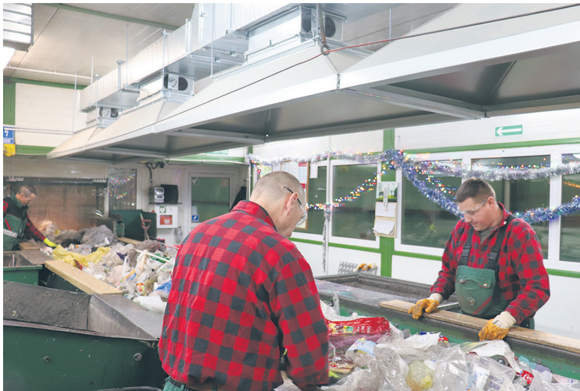
Nowy układ wentylacji ma zapewnić odpowiednie warunki pracy osobom w kabinie sortowniczej
