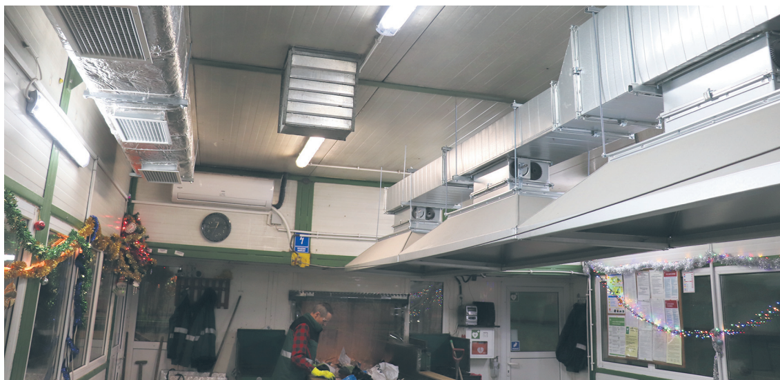
Zamontowana instalacja zapewni odpowiednią wymianę powietrza i temperaturę w kabinie sortowniczej
