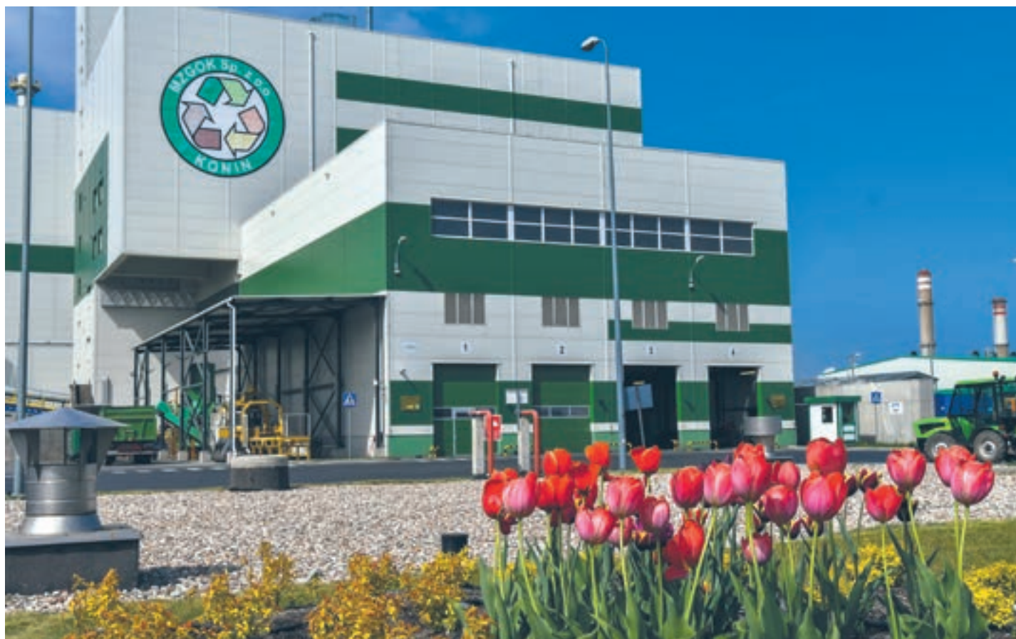
■ Zakład Termicznego Unieszkodliwiania Odpadów Komunalnych w Koninie to jedna z najnowocześniejszych spalarni w kraju
