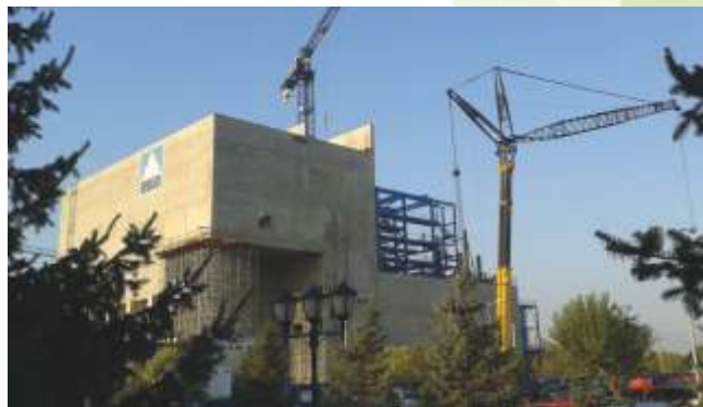
Ogólny widok budowy
