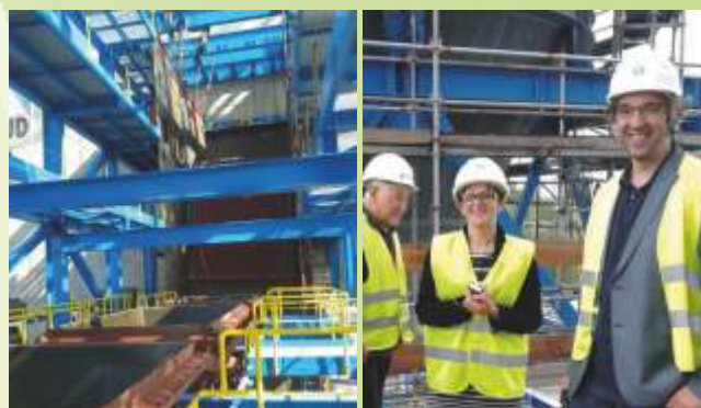
Montaż ścian kotła
