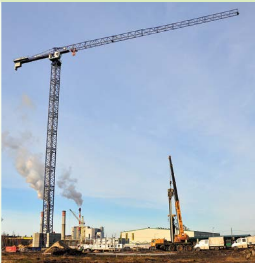
Ruszyły roboty na placu budowy.
