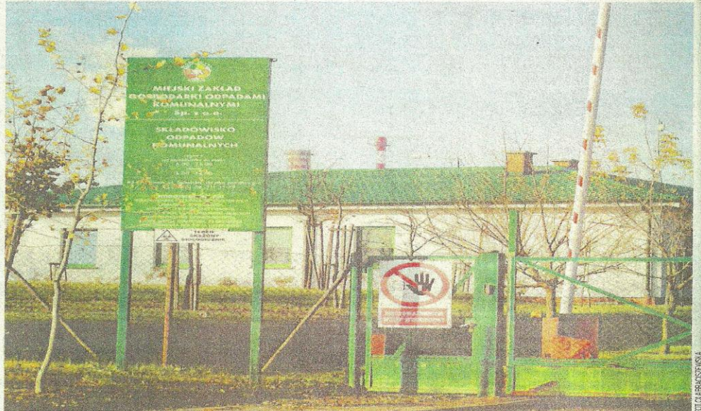
Budowa spalarni ruszy w przyszłym roku, ale na jej rozruch poczekać będziemy aż do 2015 roku
